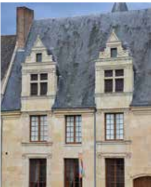
Maison Renaissance de Montoire
